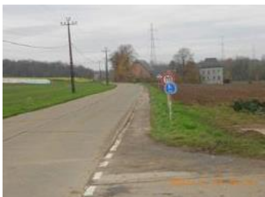
Rue de Rhisnes piste cyclable existante à rénover et à sécuriser
