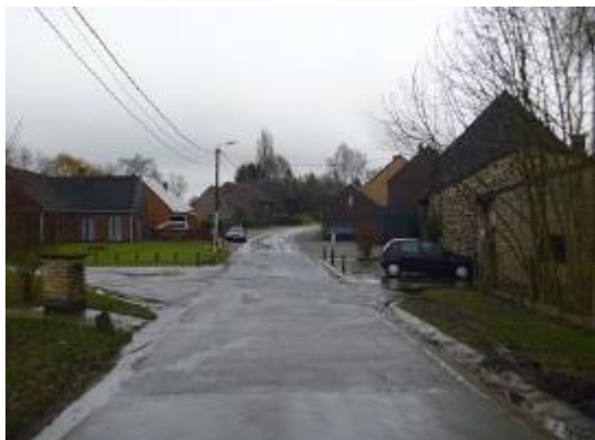
Traversée rue de Vedrin à sécuriser
